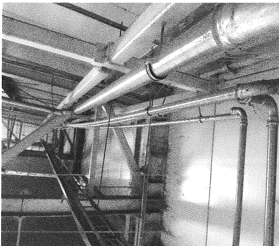
Fot. nr 7. Rozszczelnienie pionowe i poziome sekcji oraz zasyfonowanie sekcji
