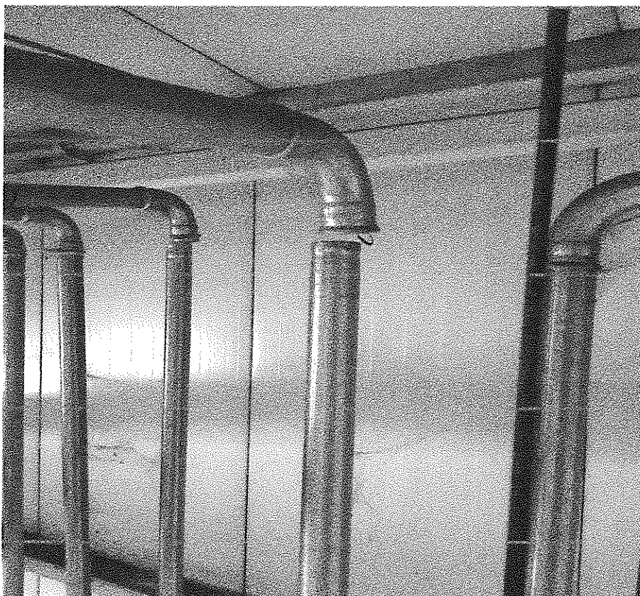
Fot. nr 6. Rozszczelnienie pionowe sekcji
