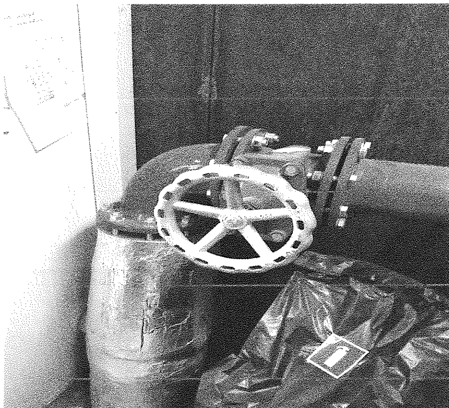
Fot. nr 2 Zasuwa kołnierzowa w pomieszczeniu rozdziału
