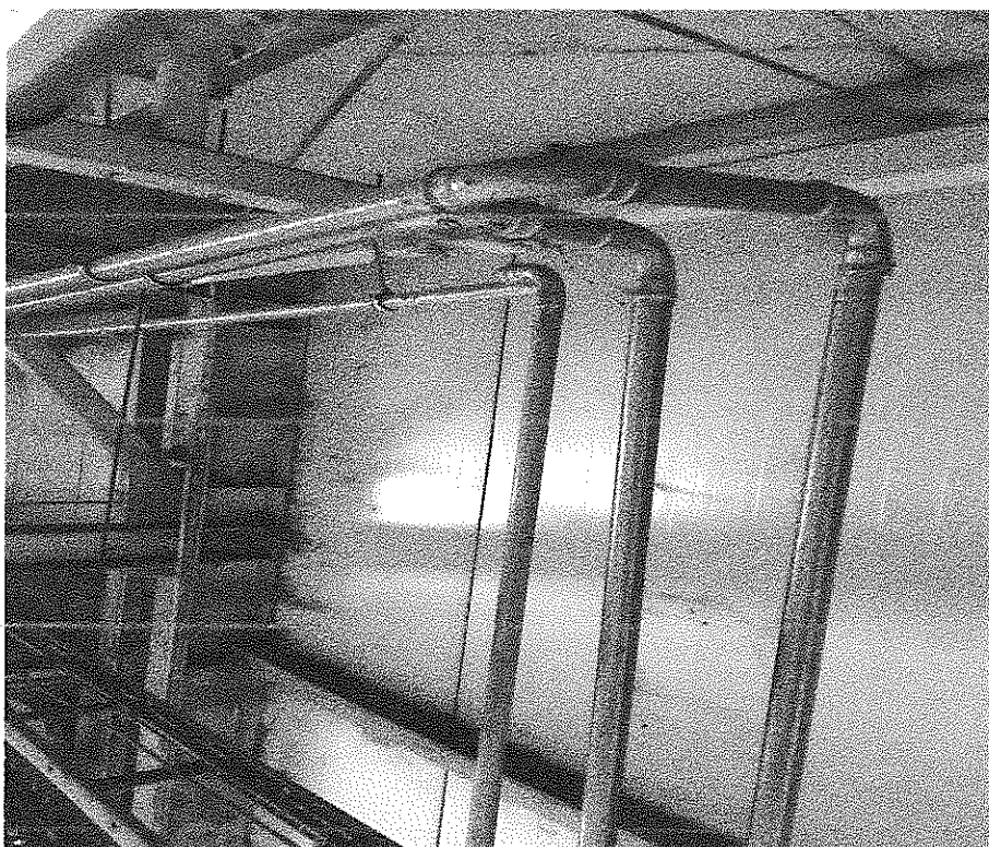
Fot. nr 6. Rozszczelnienie pionowe i poziome sekcji
